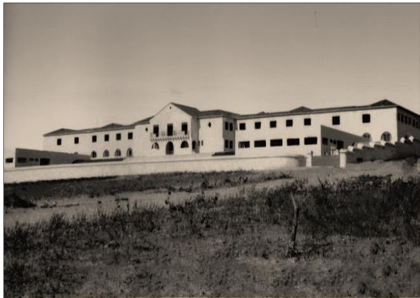
Foto 1: Fachada do prédio do Estadual da Prata
