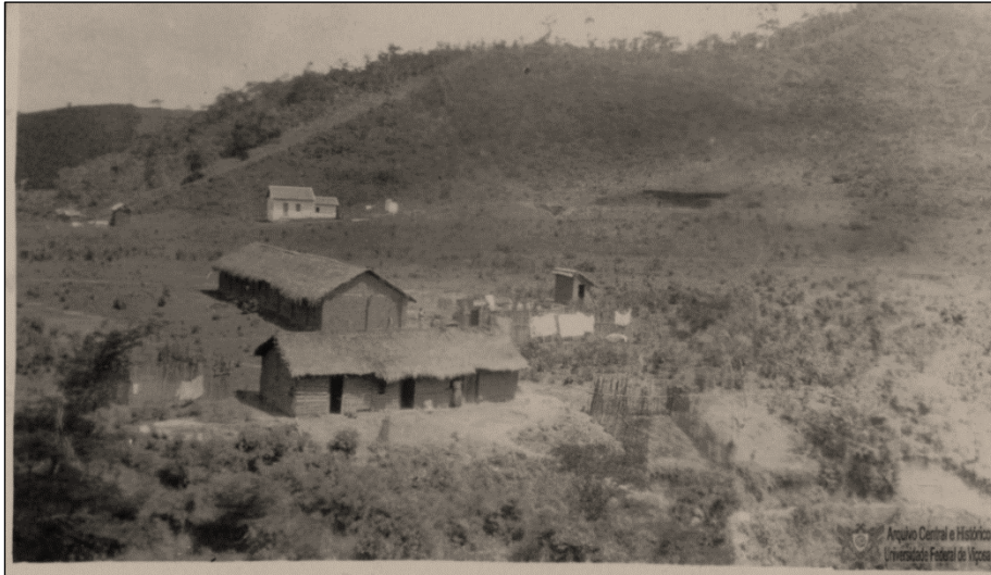
Figura 5 - Habitação dos operários da construção da Escola, feita de taipa e pau-a-pique (1922). Percebe-se a presença de fossas sanitárias tanto nos barracos da frente quanto no do fundo.
