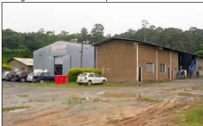
Figura 1 – Fachada do Galpão da ETEC de Piedade
