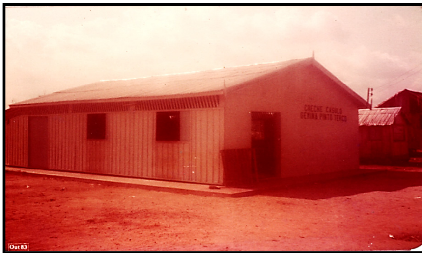
FIGURA 2 – VISTA DA FACHADA E LATERAL DA CRECHE CASULO GENINA PINTO TERCO.
