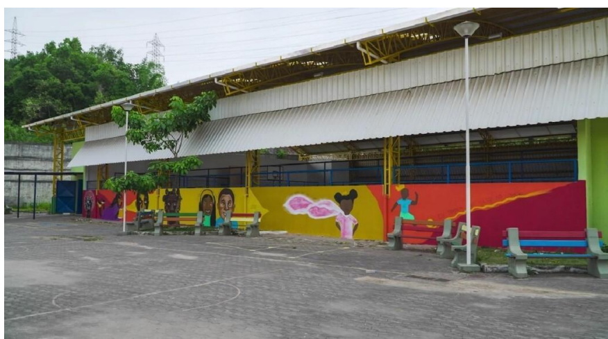
FIGURA 3 – Muro da quadra da escola
