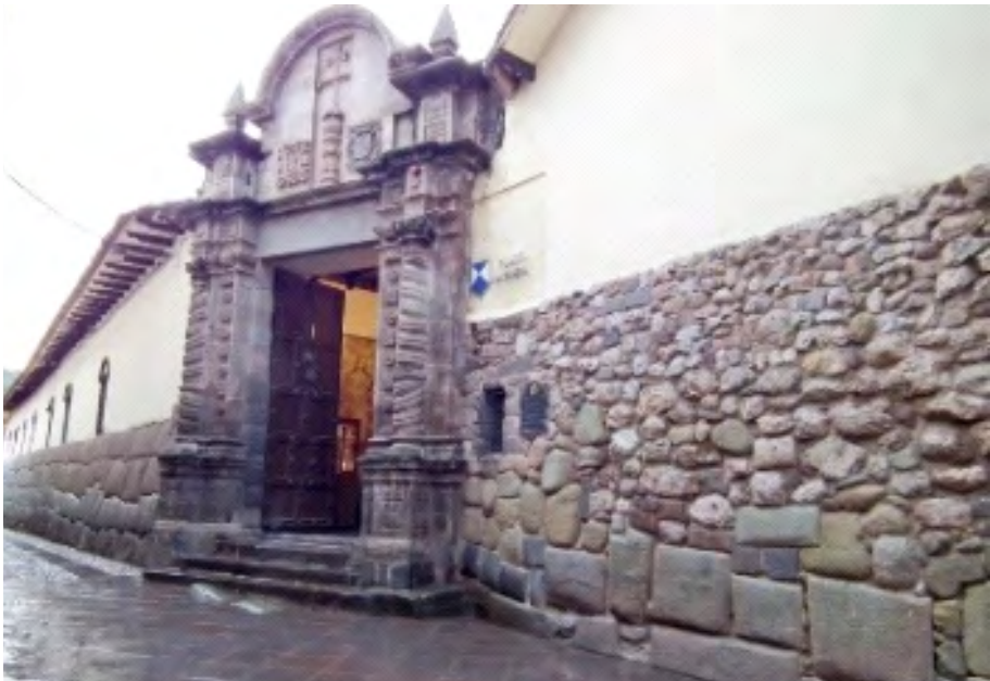
Foto 9 - Palácio do arcebispo, construído sobre o palácio do Inca Roca. Cusco, Perú
