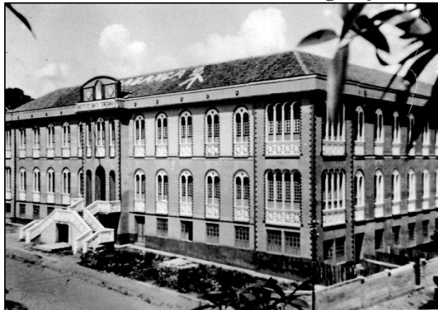
Figura 08: Prédio do IST na data de sua inauguração, 1944.
